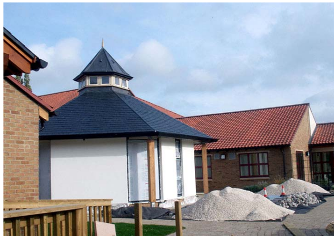
Billede 4: Udsigt over New Farleigh Hospice kapel, formet som et fyrtårn (under opførelse)
